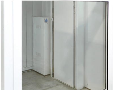
Solución MRL, control y central dentro del hueco.
