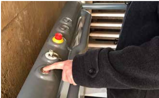
Accionamiento por pulsación constante
