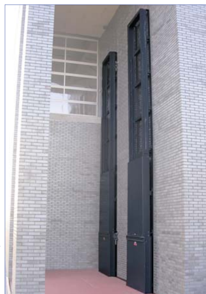
Figure 4. Ascenseur monte-charges guidage à double colonne EH/DCL.
